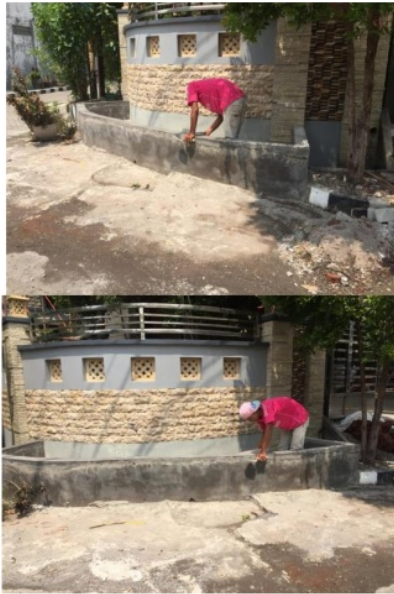
Gambar 2 Kegiatan pembangunan taman RT
