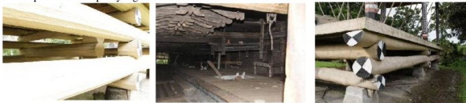
Gambar 21. Balok Tumpuk dan "gladak" arsitektur Batak Simalungun (Sumber: Dokumentasi Pribadi, 2013)
