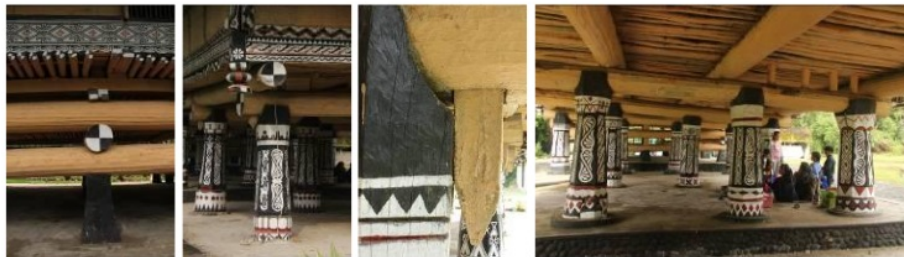
Gambar 20. Konstruksi Balok Tumpuk (Sumber: Dokumentasi Pribadi, 2013)
