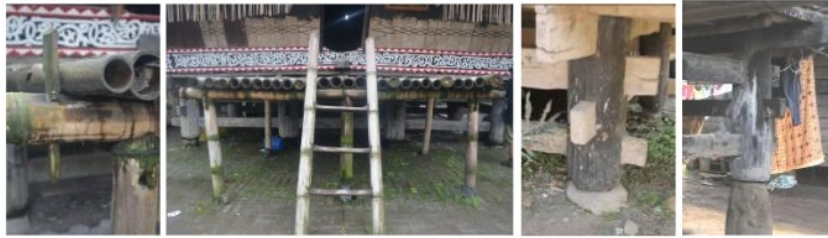
Gambar 15. Elemen Vertikal (Kolom) (Sumber: Dokumentasi Pribadi, 2013)
