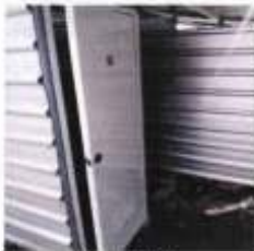
Gambar 7. Pintu yang sudah dipasang
