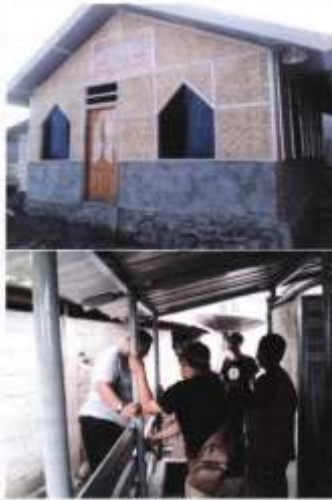
Gambar 1. Kondisi MCK di Dusun Batu Sela
