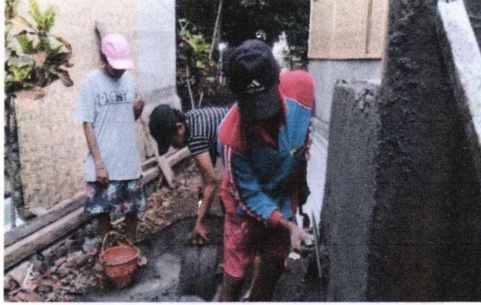
Gambar 5. Membuatudukan tandon 1100 Liter
