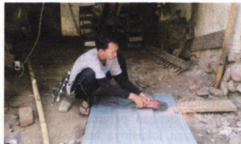
Gambar4. Melanjutkan kegiatan memasang Spandek
