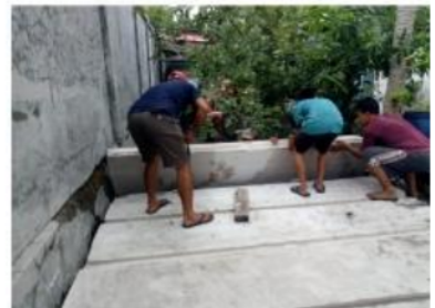
Gambar 8. Memasang penutup saluran drainase
