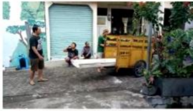
Gambar 6. Memasang penampang atas drainase
