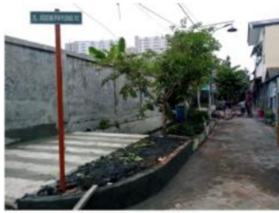
Gambar 10. Merapikan bagian tepi penutup drainase
