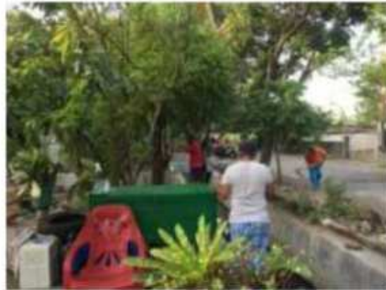
Gambar 4. Penataan area yang akan di- paving
