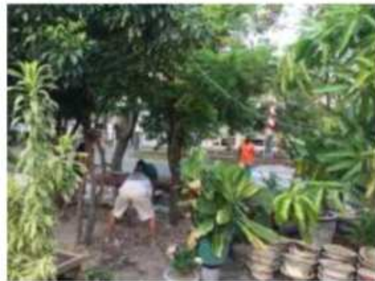
Gambar 3. Perataan lokasi dan pemadatan pasir sebagai media paving
