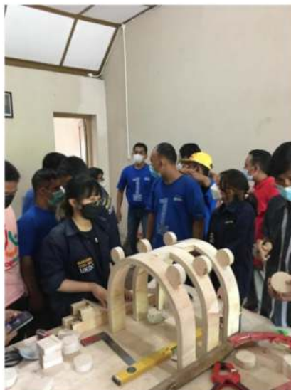
Gambar 3. Proses perakitan antar bilah yang telah dibending
