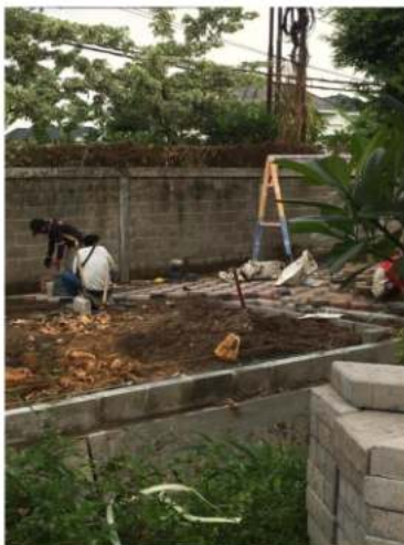
Gambar 3. Proses pemerataan dan penentuan letak titik alat bermain anak
