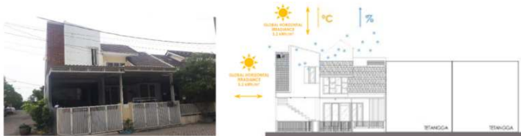
Gambar 3. Foto obyek studi (rumah tinggal—sisi depan) Sumber: Dokumentasi prbadi, 2020
