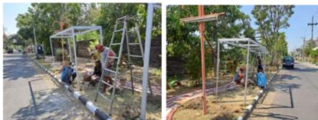
Gambar 4. Pemasangan Gawangan Pada Lokasi Taman Warga
