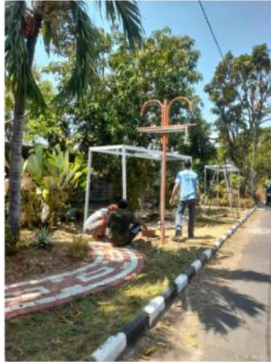
Gambar 3. Proses pemasangan lampu panel surya pada area taman
