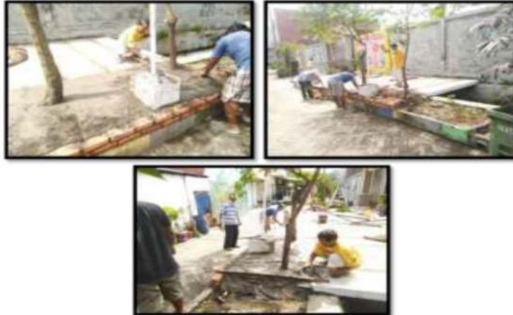
Gambar 6. Pemasangan batu bata dan pembuatan Lantai
