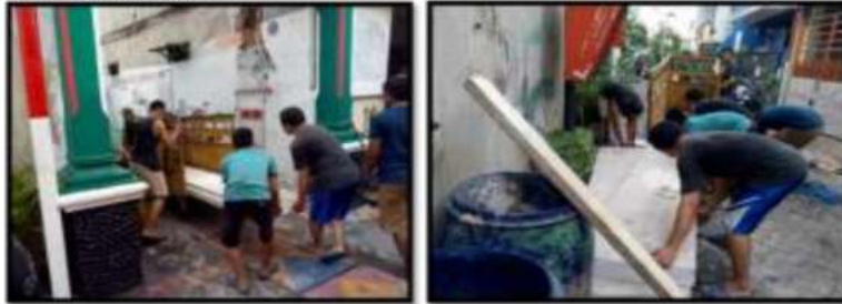
Gambar 4. Pemindahan panel lantai ke lokasi
