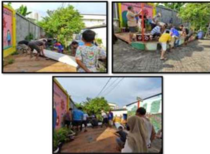
Gambar 5. Pemasangan panel lantai di atas saluran drainase
