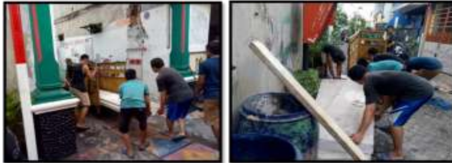
Gambar 4. Pemindahan panel lantai ke lokasi
