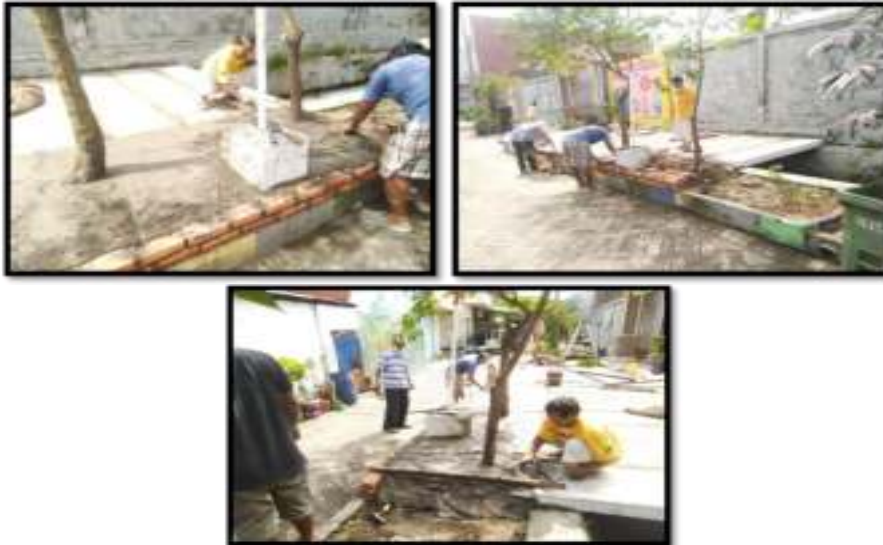
Gambar 6. Pemasangan batu bata dan pembuatan Lantai
