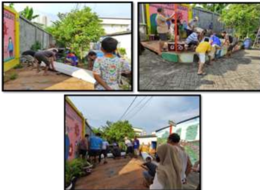
Gambar 5. Pemasangan panel lantai di atas saluran drainase
