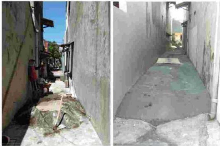
Gambar 3. Pengecoran Brandgang (Sumber: Dokumentasi Kegiatan, 2021)
