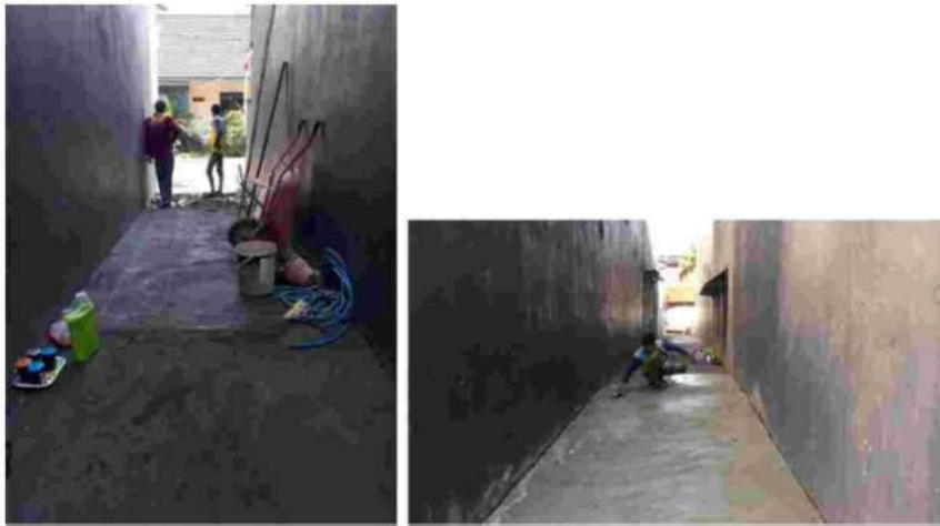
Gambar 4. Pekerjaan Akhir (Sumber: Dokumentasi Kegiatan, 2021)
