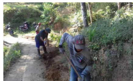
Gambar 2. Penggalian untuk Pipa Air (Jln.Propinsi)
