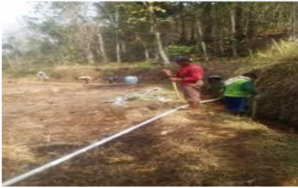
Gambar 3. Pemasangan Pipa Air (Dusun Keranjik)
