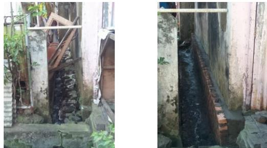
**Gambar 5. Saluran Pembuangan Air yang belum dan sudah diperbaiki**
