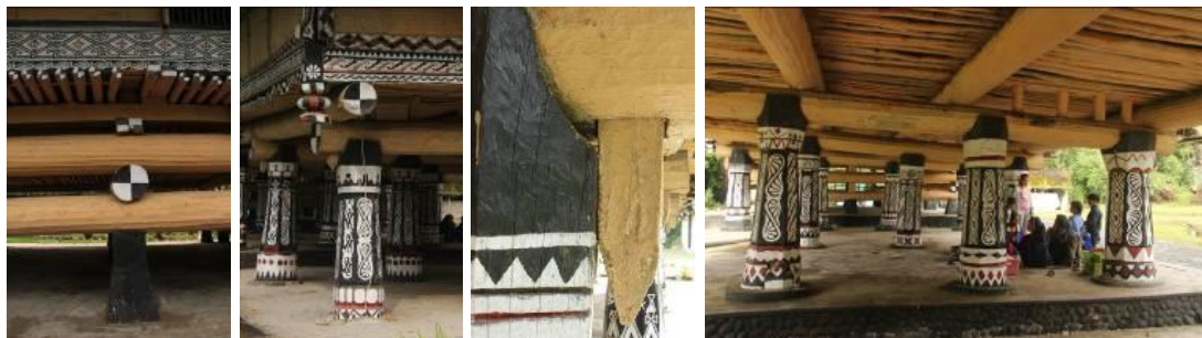
Gambar 20. Konstruksi Balok Tumpuk (Sumber: Dokumentasi Pribadi, 2013)
