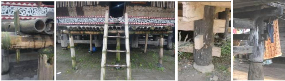
Gambar 15. Elemen Vertikal (Kolom) (Sumber: Dokumentasi Pribadi, 2013)
