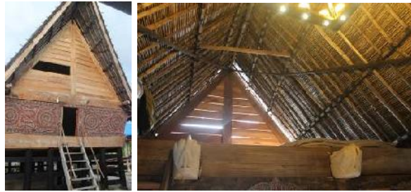
Gambar 9. Kisi-kisi lantai loteng (Sumber: Dokumentasi Pribadi, 2018)
