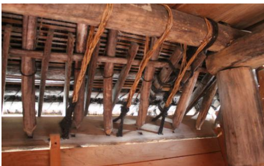
Gambar 12. Ikatan rotan pada bagian bungkulan dan batahan (Sumber: dokumentasi peneliti, 2018)
