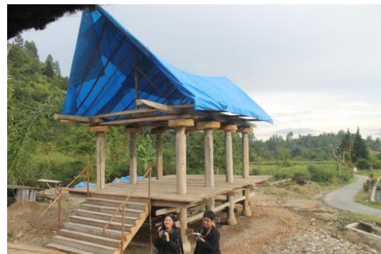
Gambar 13. Bangunan Sopo (lumbung) (Sumber: dokumentasi peneliti, 2018)
