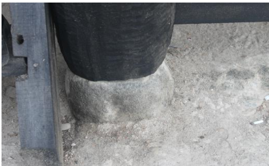
Gambar 11. Teknik pondasi umpak pada rumah adat Batak Toba (Sumber: dokumentasi peneliti, 2018)
