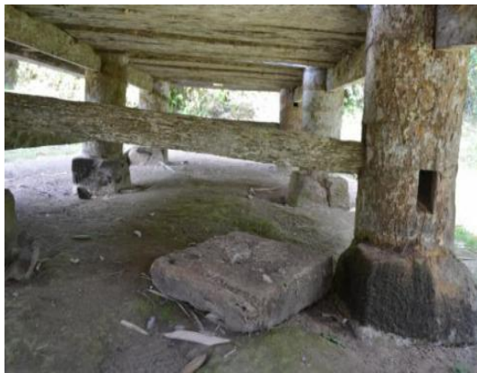
Gambar 2. Konstruksi purus lubang-umpak (Sumber: dokumentasi peneliti, 2013)
