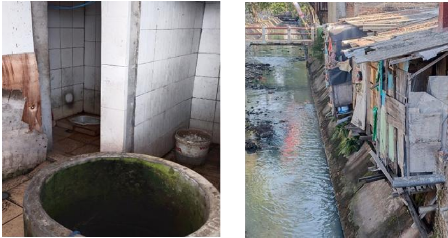
Gambar 10.1: Kondisi Sanitasi di Surabaya
