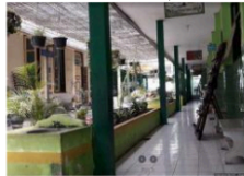
Gambar 4. Selasar di Sekeliling Bangunan SDN Ditotrum 1 Lumajang Sumber: Hendra, 2021
