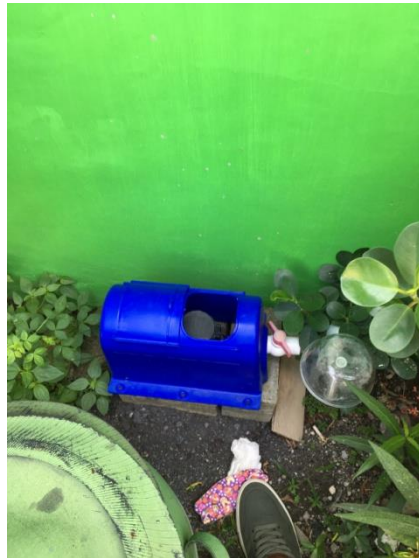
Gambar 6. Penutup pengaman meteran air PDAM Sumber: Tim pengabdian, 2023
