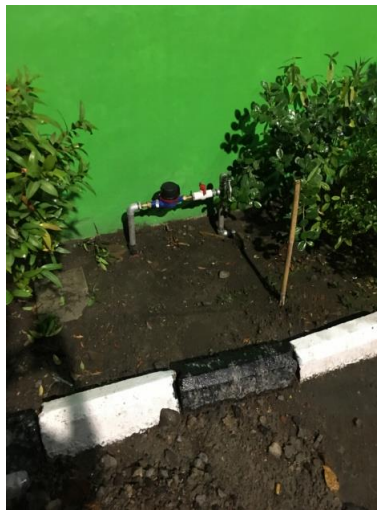
Gambar 5. Meteran air PDAM terpasang Sumber: Tim pengabdian, 2023
